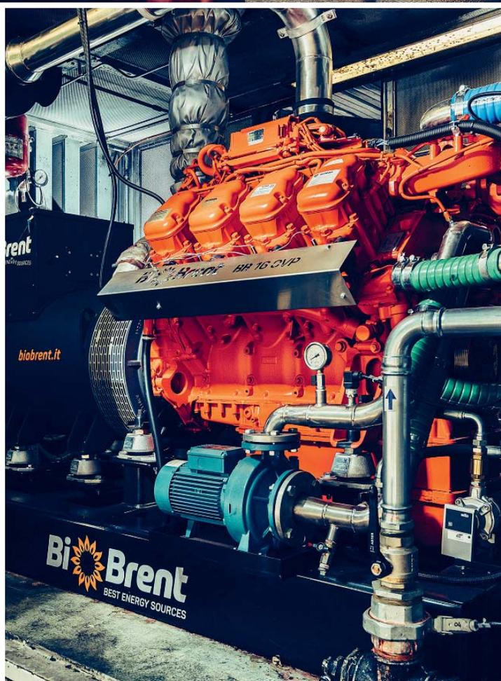
Moteur Scania installé sur un cogénérateur BioBrent chez Mecc Alte.
